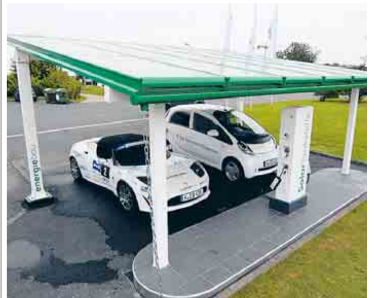
Wie ein normales Carport wirkt die Solartankstelle auf den ersten Blick. An die „Zapfsäule“ können zwei Fahrzeuge gleichzeitig angeschlossen werden. BILD: RÖSGEN
